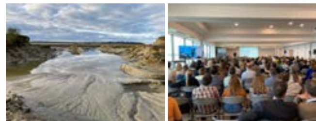
▲ Brèche de la digue de Beaussais et colloque au palais des congrès à St-Malo
